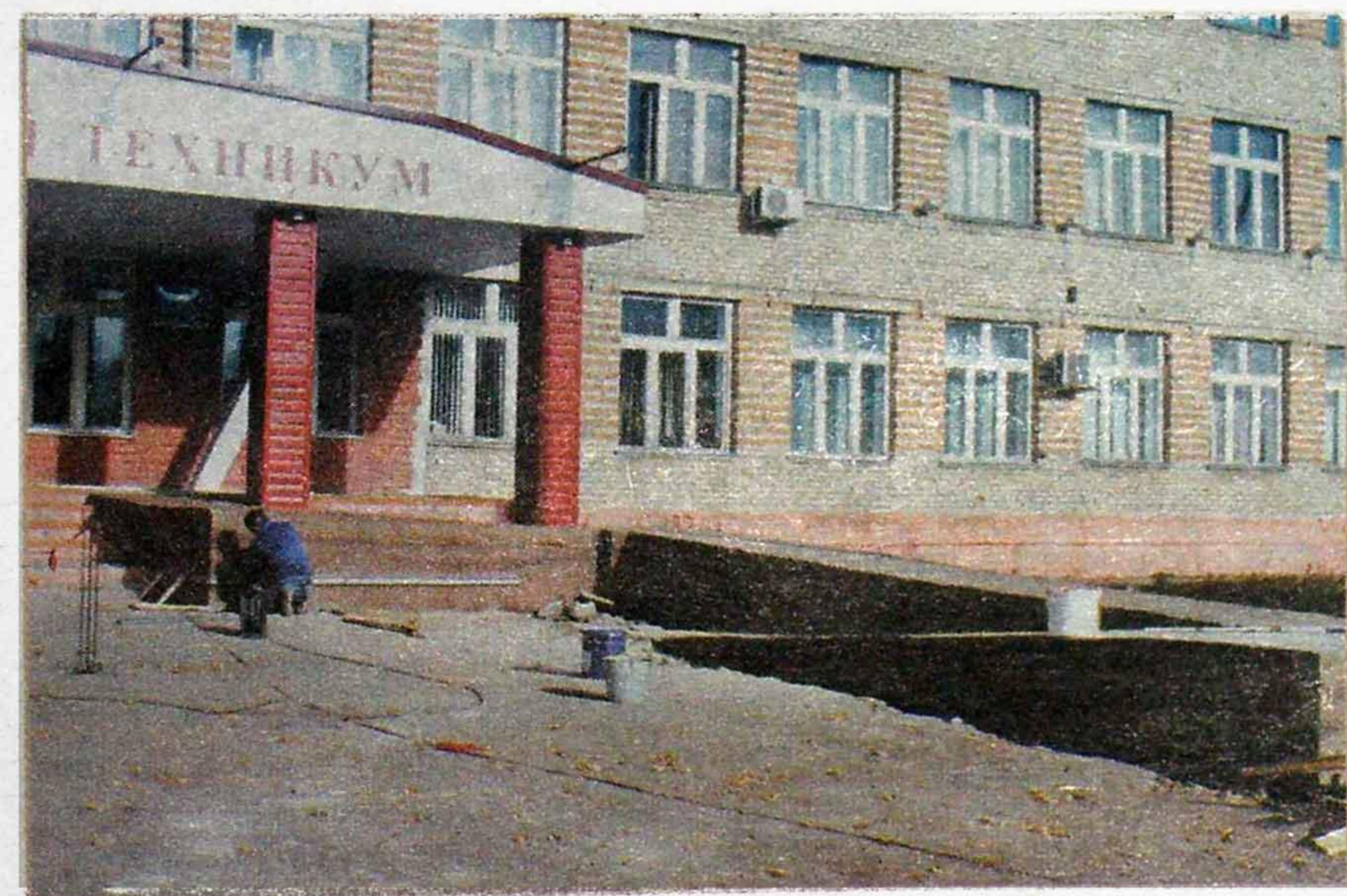
Идут работы по строительству пандуса для инвалидов-колясочников
