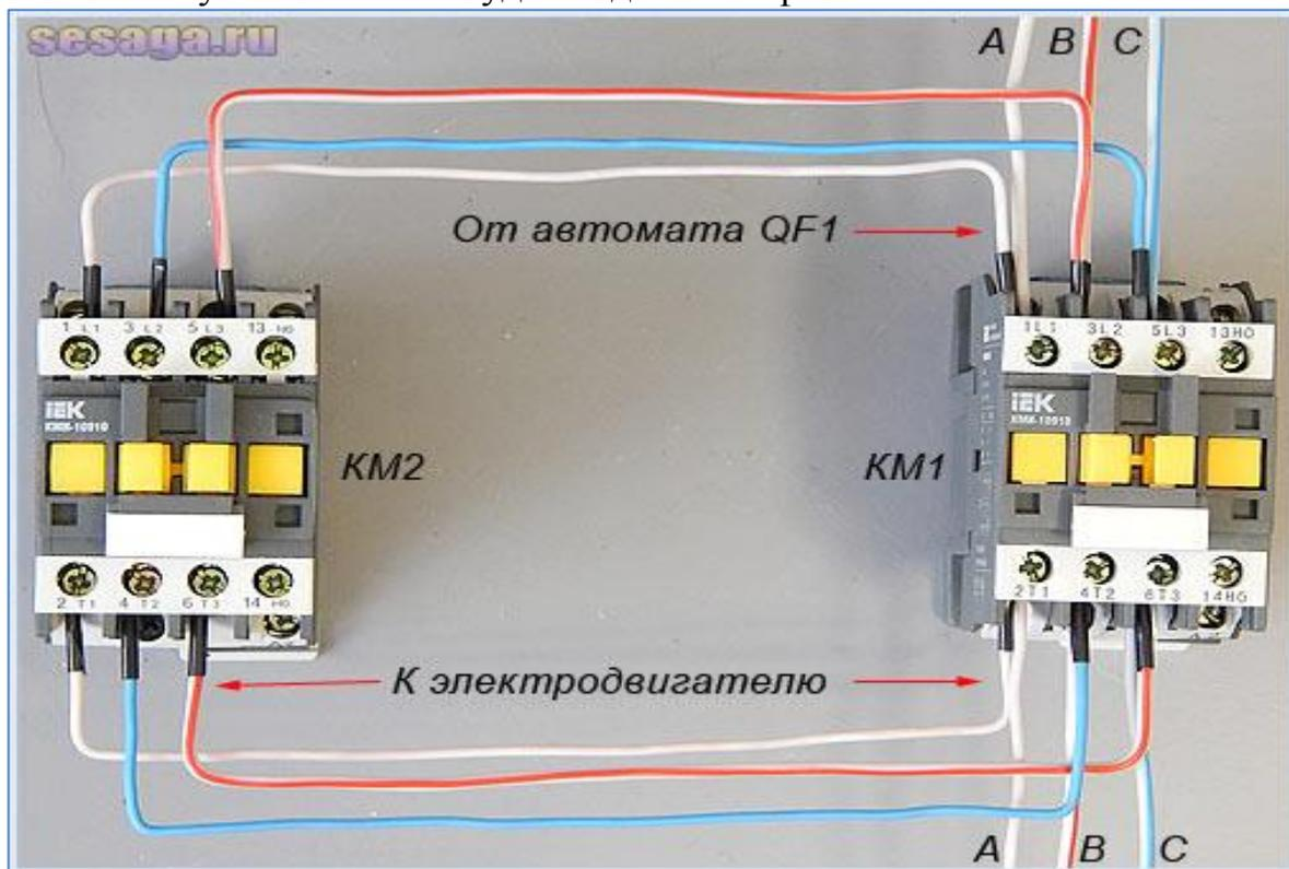
Фаза «С» синим проводом заходит на вход **правого** контакта пускателя **КМ1** и переключкой заводится на **средний** вход пускателя **КМ2**. С выхода **среднего** контакта **КМ2** фаза переключкой заводится на **средний** выход **КМ1**, и тем самым, встает на место фазы «В». Теперь на обмотку №2, при включении пускателя **КМ2** будет подаваться фаза «С». Двигатель будет вращаться в правую сторону.
